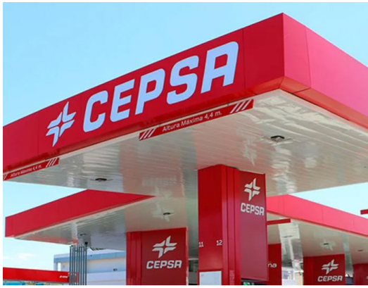
CEPSA | Huelva, Spanien Dachanlagen KCR
