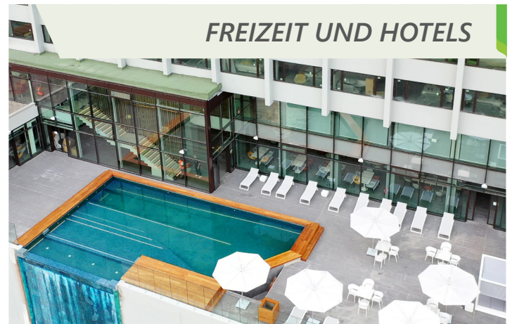
PULLMAN ABIDJAN | Abidjan, Elfenbeinküste Kälteanlagen KWE
