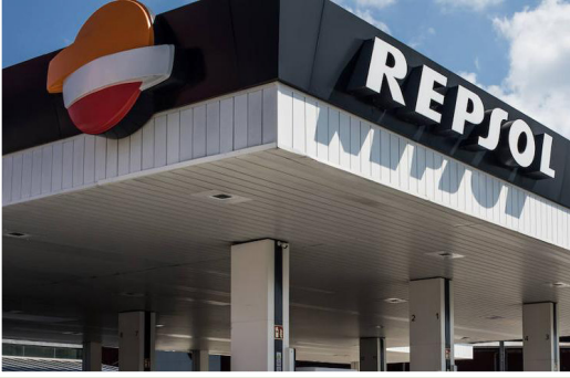
RAFFINERIE REPSOL | Puertollano, Spanien Kälteanlagen KWA
