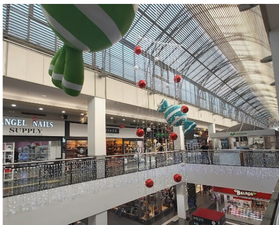
EINKAUFSZENTRUM BARICENTRO | Barberá del Vallés, Spanien Luftaufbereitungsgeräte
