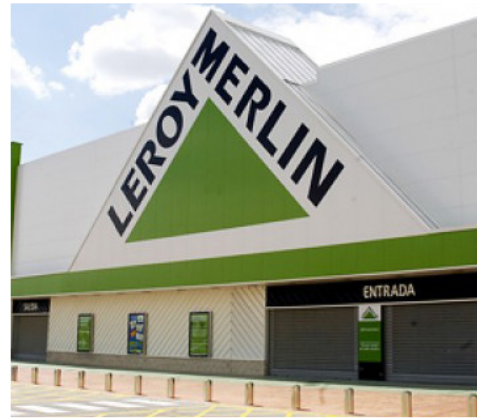
LEROY MERLIN | Târgoviște, Rumänien Dachanlagen KCR
