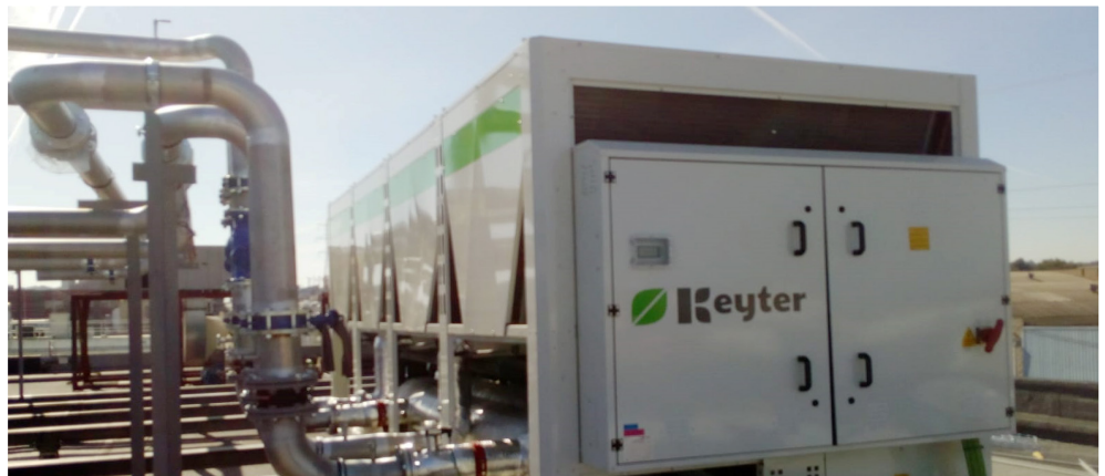
EFTEC AUTOMOBILINDUSTRIE | Romanshorn, Schweiz Kälteanlagen KWM
