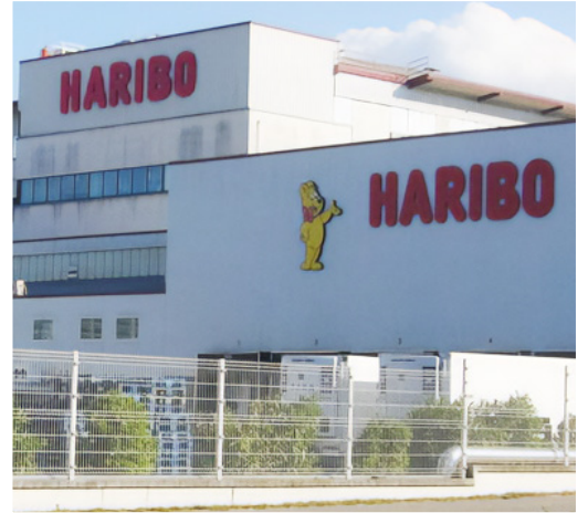
HARIBO | Girona, Spanien Kälteanlagen KWE
