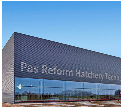
PAS REFORM | Verschiedene Kälteanlagen KWE, KWM
