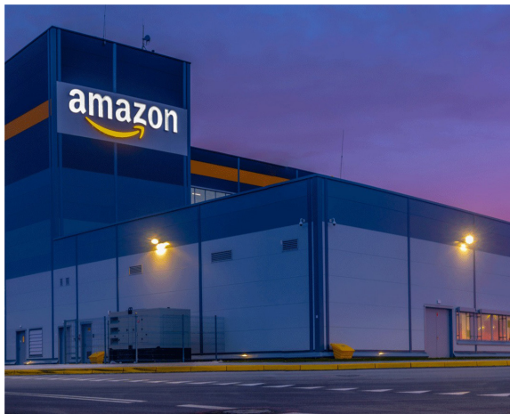
AMAZON | Alcalá de Guadaíra, Spanien Komplettsysteme KCC
