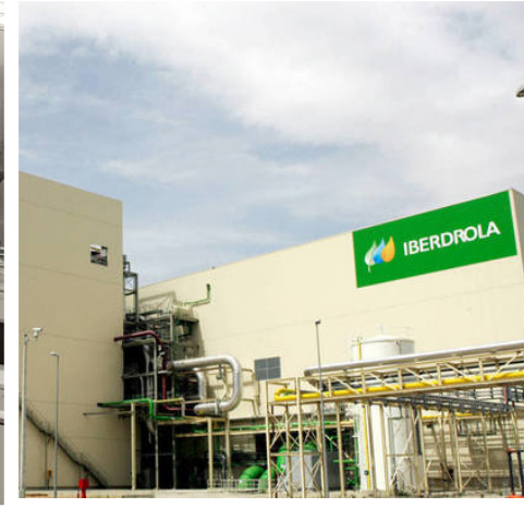
IBERDROLA | Arcos de la Frontera, Spanien Dachanlagen KCR
