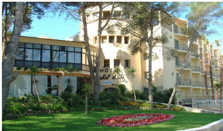
HOTEL SOL D'OR | Salou, Spanien Wärmepumpen KWE
